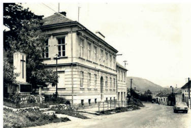
Základní devítiletá škola.
